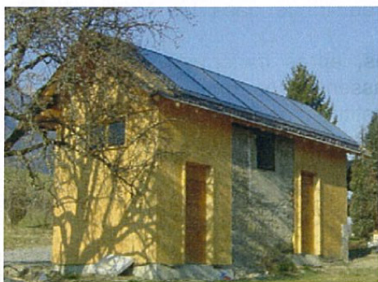
Panneaux solaires thermiques
